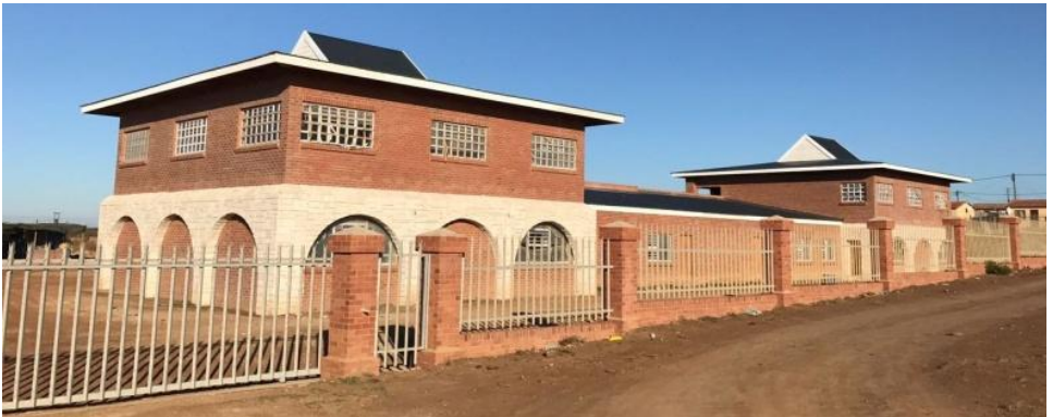
Voorkant van de nieuwbouw, eerste fase.
